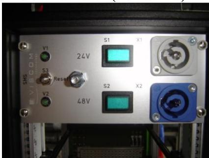
2. Alle Kabel vom Schrittmotoreinschub abklemmen \ lösen. Tipp: Beschriftung prüfen
